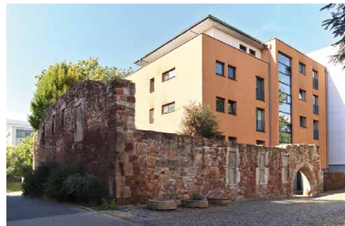
Die Mauerreste und die Mühlsteine in der Mühlengasse erinnern an die Unterneustädter Mühle.
