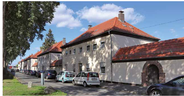
Die ersten Häuser von 1916 in der Steinigkstraße
