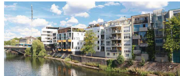
Blick auf die Uferbebauung der Unterneustadt von der Walter-Lübcke-Brücke aus. Am Seil über die Fulda schwebt der „Blue Dancer“.
