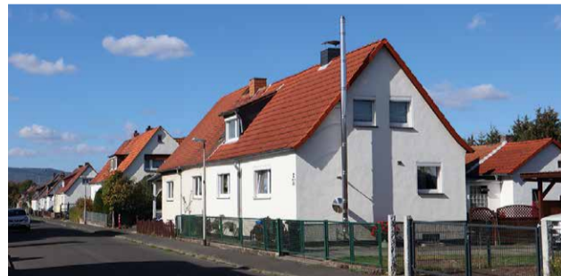
Siedlungshäuser der Erlendfeldsiedlung
